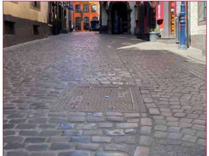
Ergebnis nach der Verfugung mit ROMPOX® - D2000
