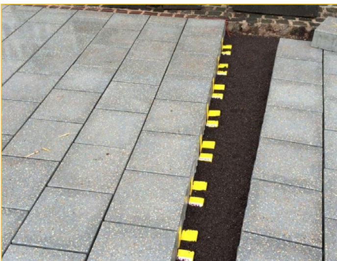
Aufnahme des Pflasters und Einbau der ISAT ec ® Erdanker
